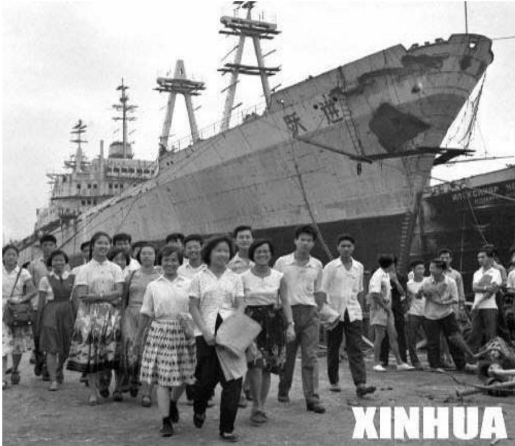
1958年11月27日，中国第一艘万吨远洋货轮“跃进号”下水。这艘远洋货轮由大连造船厂建造，全长169.9米，载货量1.34万吨，排水量为2.21万吨，能在封冻的区域破冰航行。这是归国华侨学生在大连造船厂参观正在制造的“跃进号”万吨巨轮。
